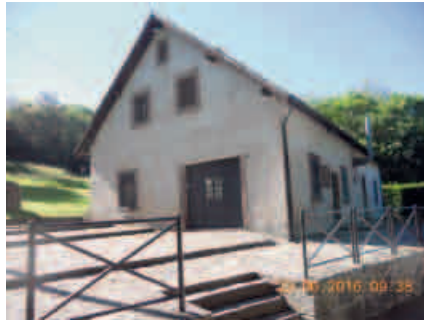
La chambre à gaz située à l'extérieur du camp
